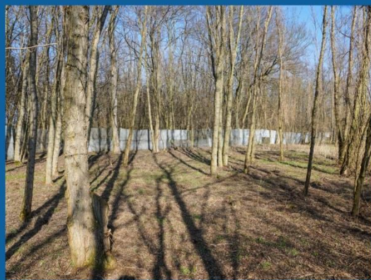
Streckmetallgitter der DDR-Grenzanlagen als Umfriedungszaun von Fort Hahneberg nahe dem Grenzübergang Staaken/Heerstraße (2); Aufnahme 2015 (Foto: Dajana Marquardt)
