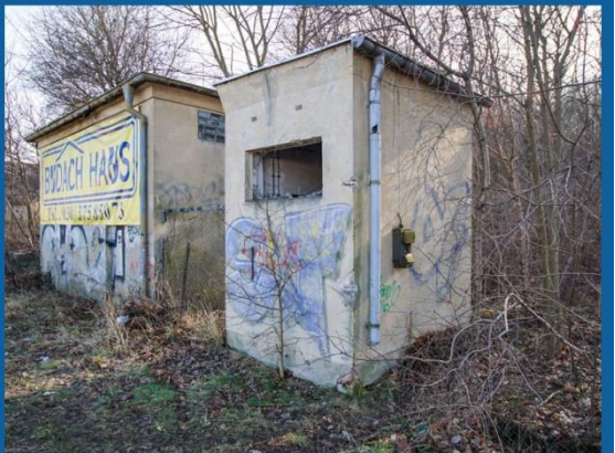
Transformatorhaus des DDR-Grenzübergangs Staaken; Aufnahme 2015 (Foto: Dajana Marquardt)
