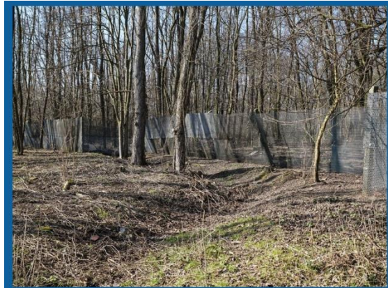
Streckmetallgitter der DDR-Grenzanlagen als Umfriedungszaun von Fort Hahneberg nahe dem Grenzübergang Staaken/Heerstraße (1); Aufnahme 2015 (Foto: Dajana Marquardt)
